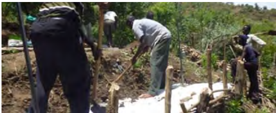
土のうにより、 傾斜地に平場・ 盛土を作成。土 壌の流出を防 止。
