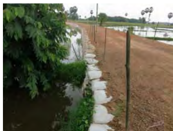
②施工後: 施工道路周辺は冠水しているが嵩上げ工事により、雨期時の通行も可能となっている。
